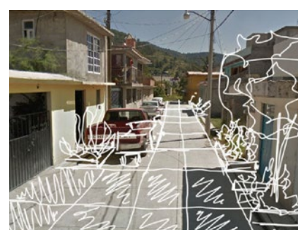
Iturbide, Acambay. Elementos a mejorar
